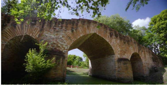
สะพานเทพนมีช่องให้เรือสามารถลอดผ่านได้ ๓ ช่อง โดยช่องตรงกลางจะเป็นช่องที่มีขนาดใหญ่กว่าอีก ๒ ช่อง
